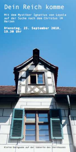
Kleine Dachgaube auf der Südseite des Steinhauses
